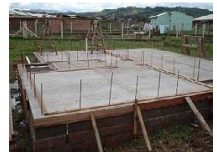
Barras de anclajes y guías colocadas en la platea de una vivienda típica.
