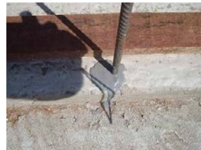
Colocación de barra de anclaje con adhesivo Epoxi.
